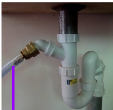
Methode 1: aansluiting met T-stuk
